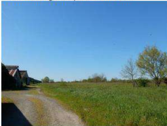
Les bâtiments agricoles présents sur le site
